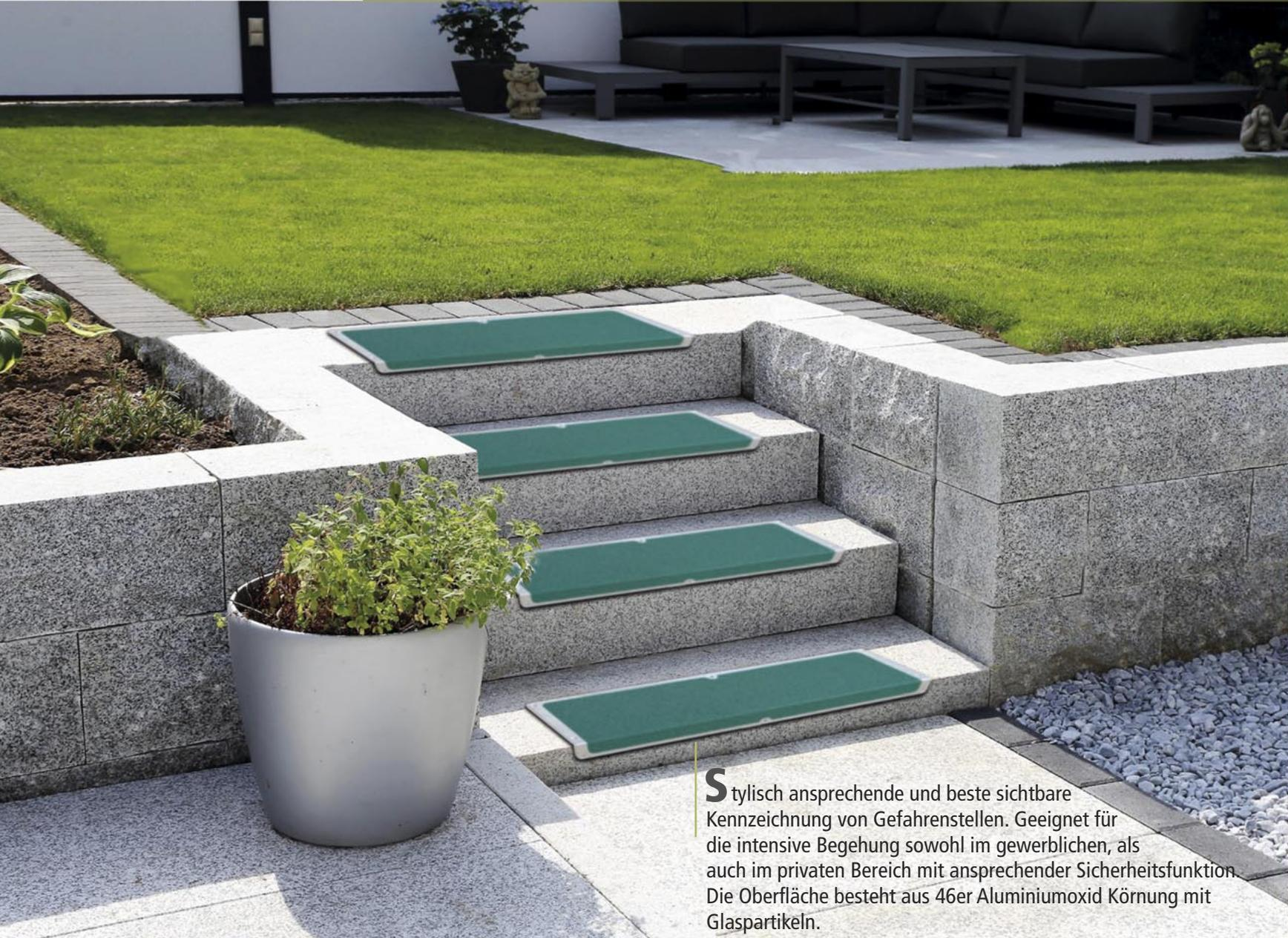
**S**tylisch ansprechende und beste sichtbare Kennzeichnung von Gefahrenstellen. Geeignet für die intensive Begehung sowohl im gewerblichen, als auch im privaten Bereich mit ansprechender Sicherheitsfunktion. Die Oberfläche besteht aus 46er Aluminiumoxid Körnung mit Glasparkeln.
